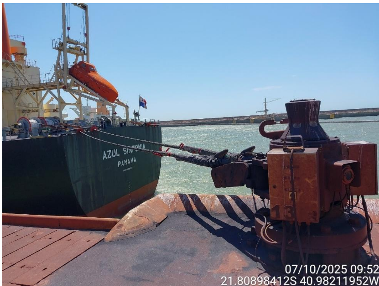
Figura 7 Muretas de contenção e sistema de atracação de navios
