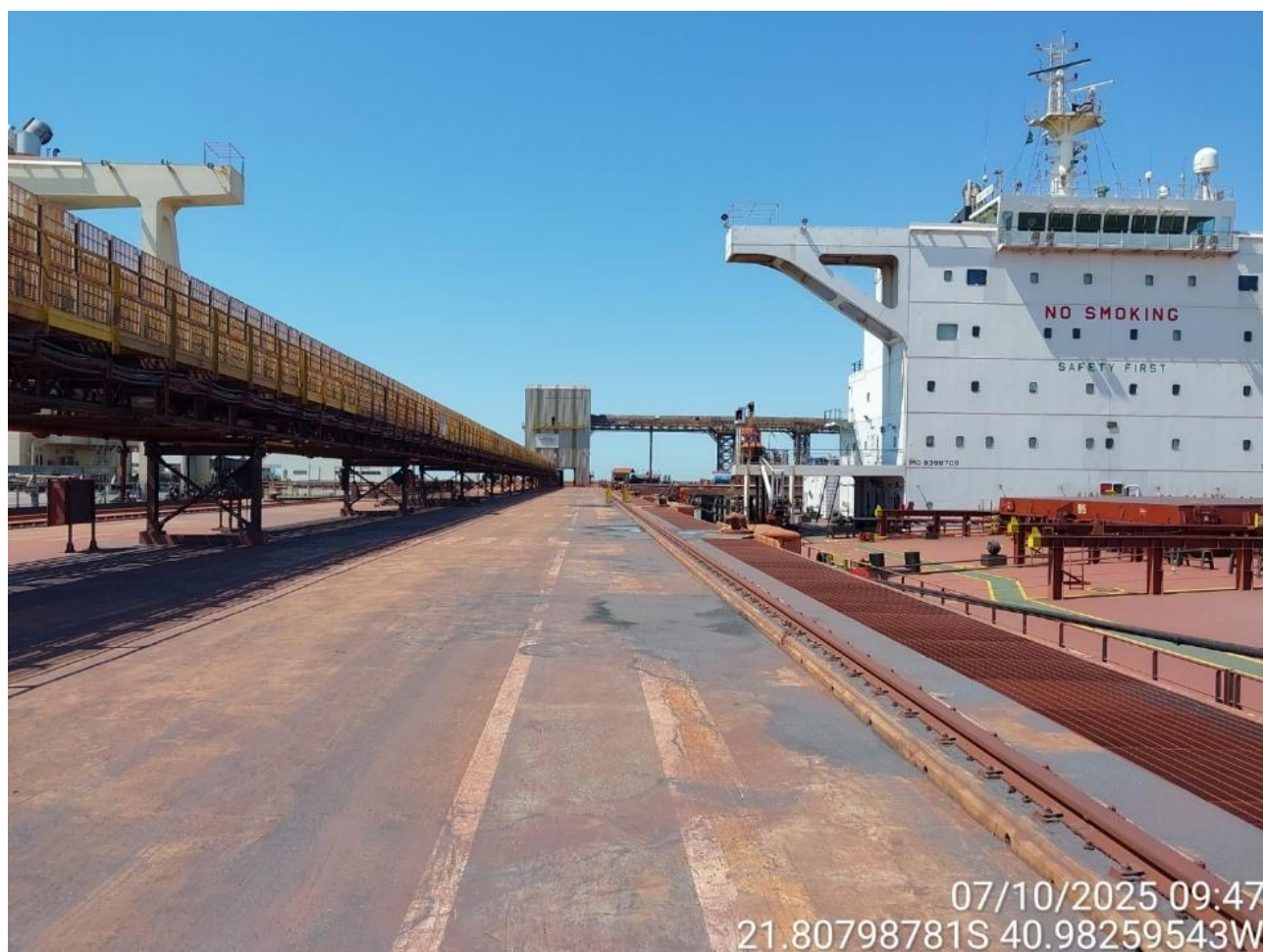
Figura 6 Sistema de canaletas no píer e condições da água
