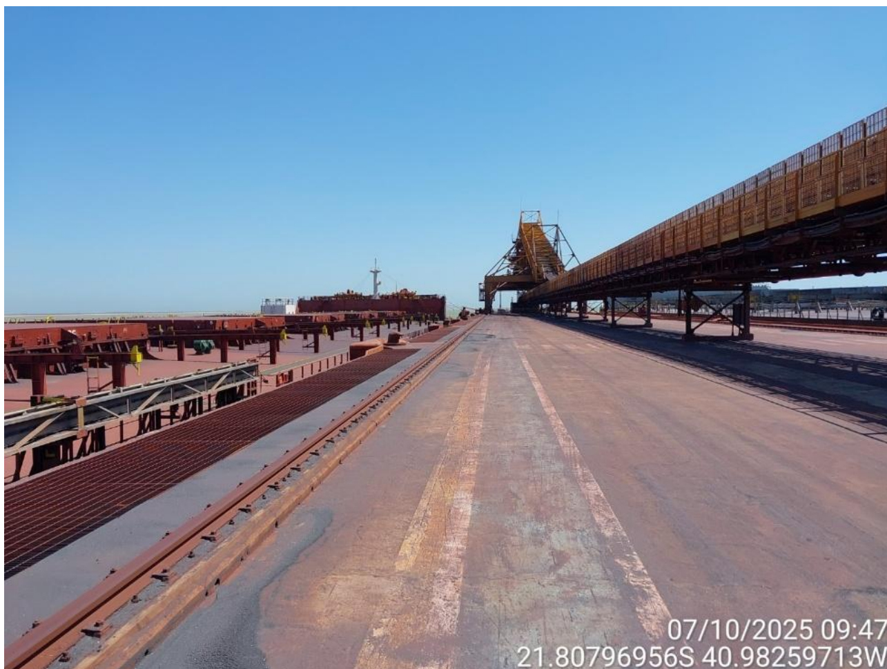
Figura 5 Pier de carregamento
