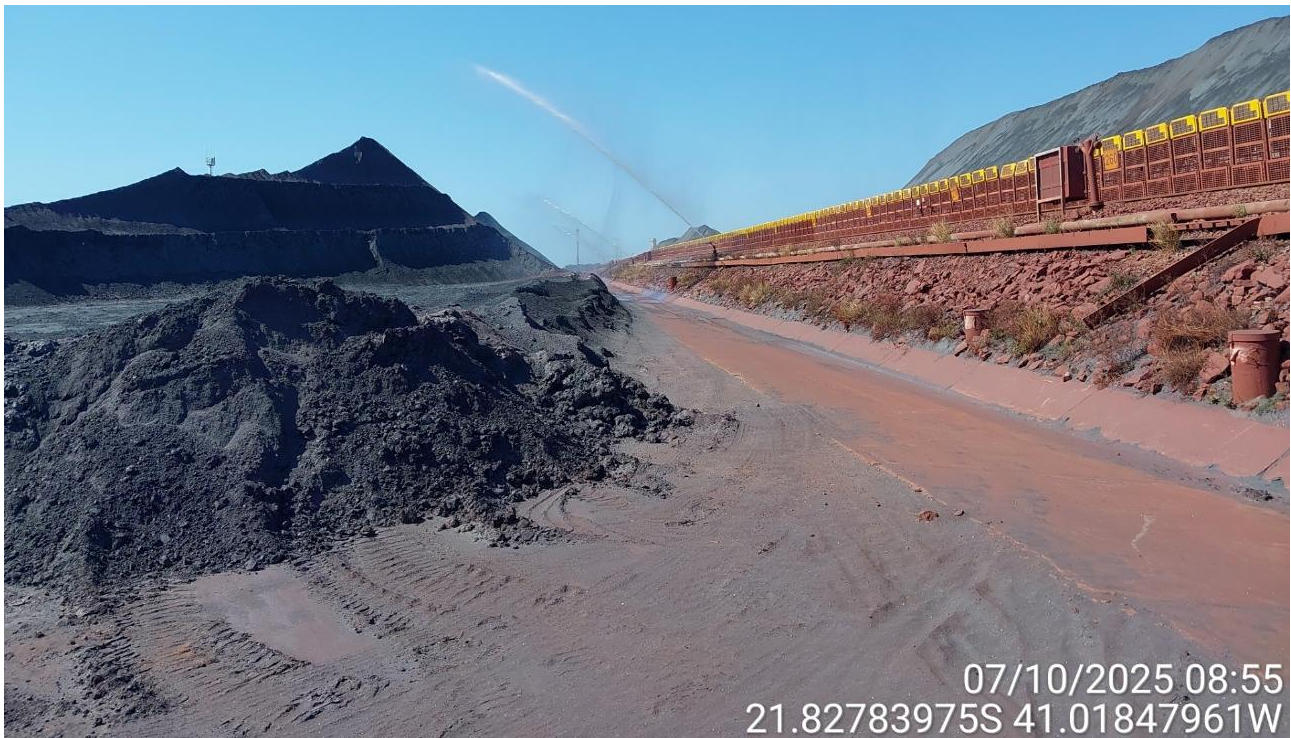
Figura 10 Pilhas de minério e empilhadeira em Operação e sistema de drenagem do pátio de minério
