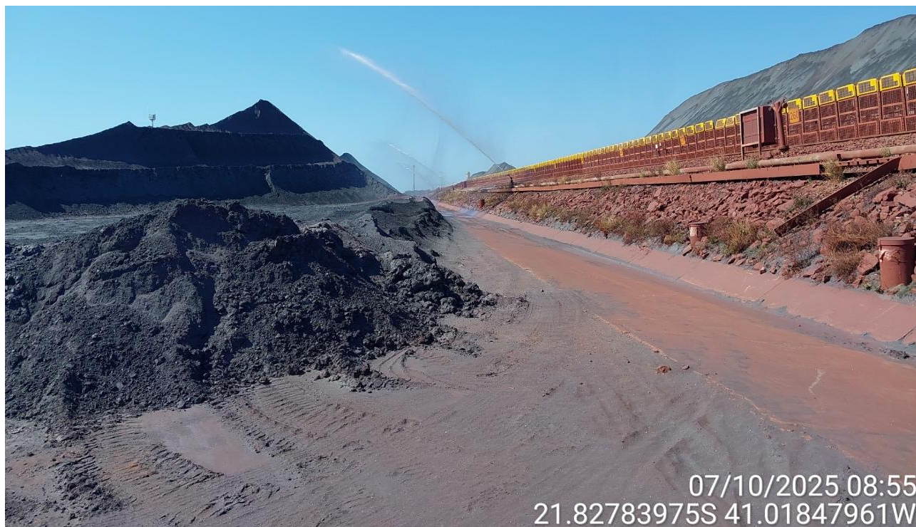
Figura 9 Pilhas de minério e empilhadeira em Operação e sistema de drenagem do pátio de minério
