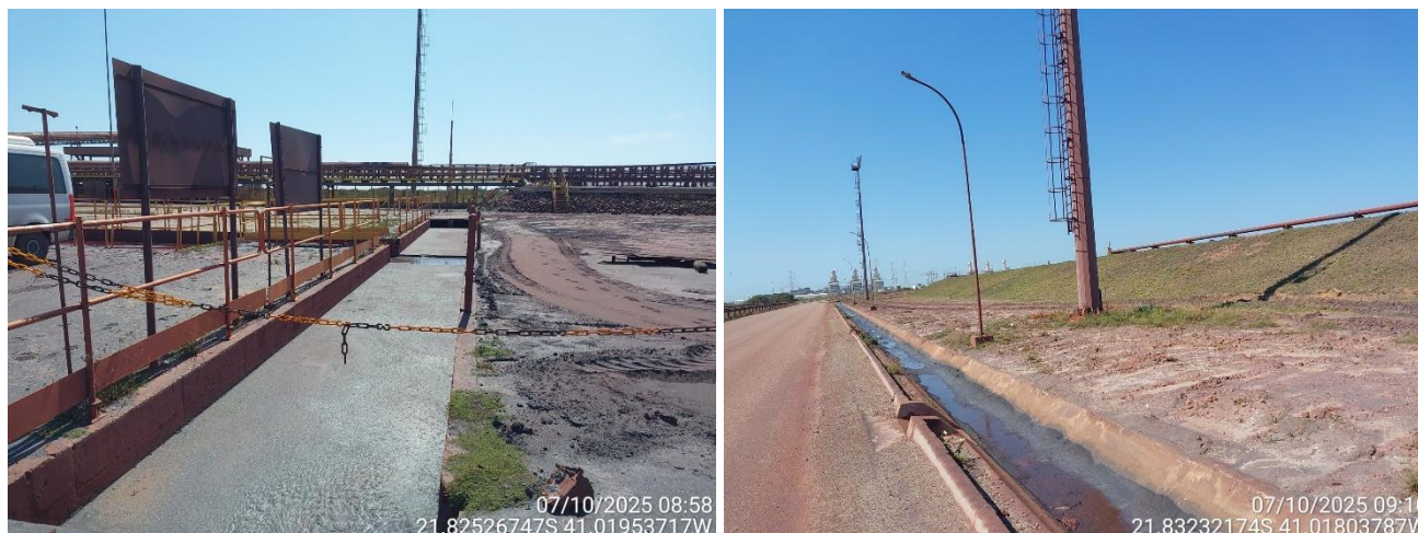
Figura 11 Sistema de drenagem do pátio de minério
