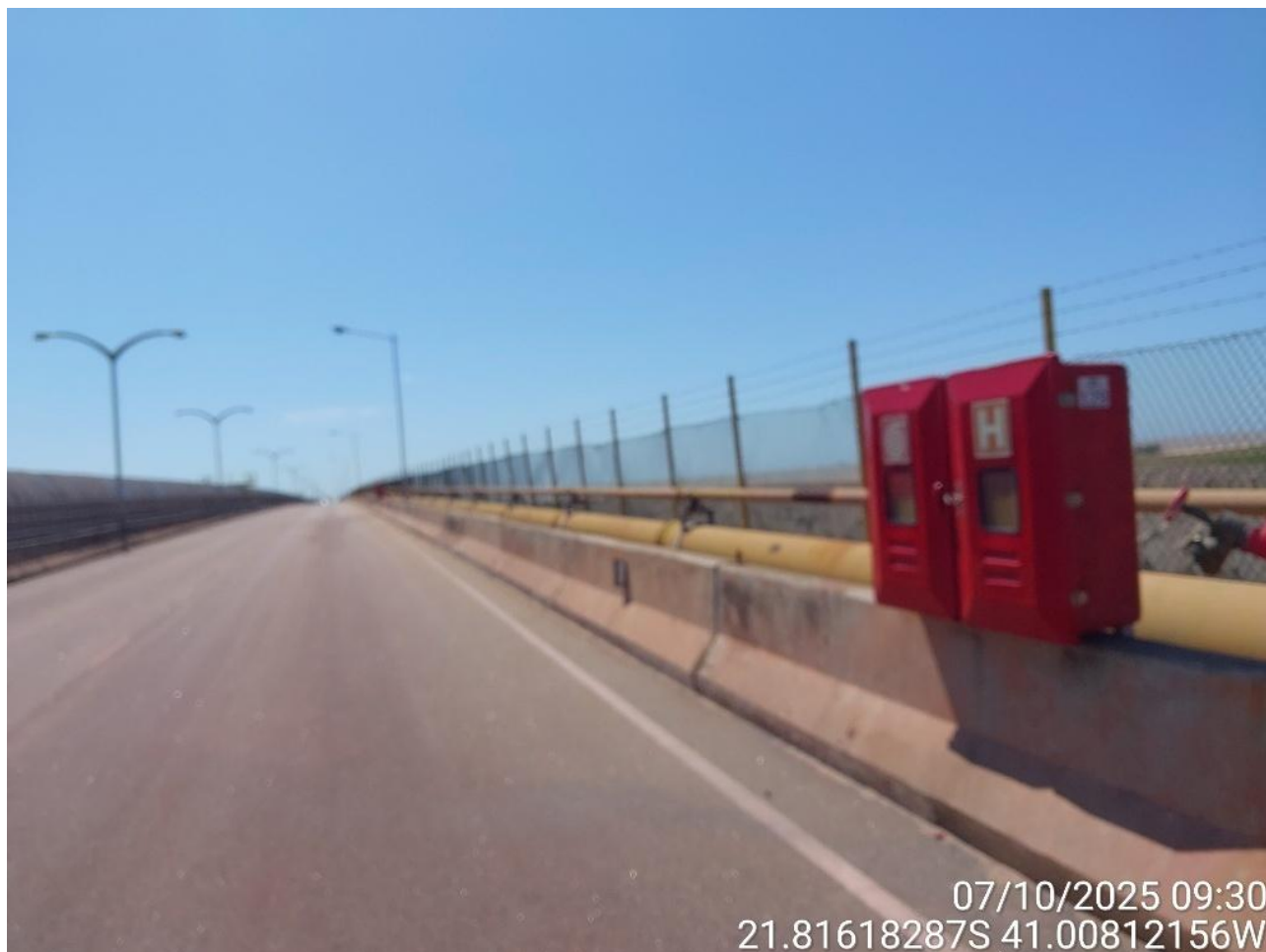
Figura 21 Exemplo de Rede de Hidrantes
