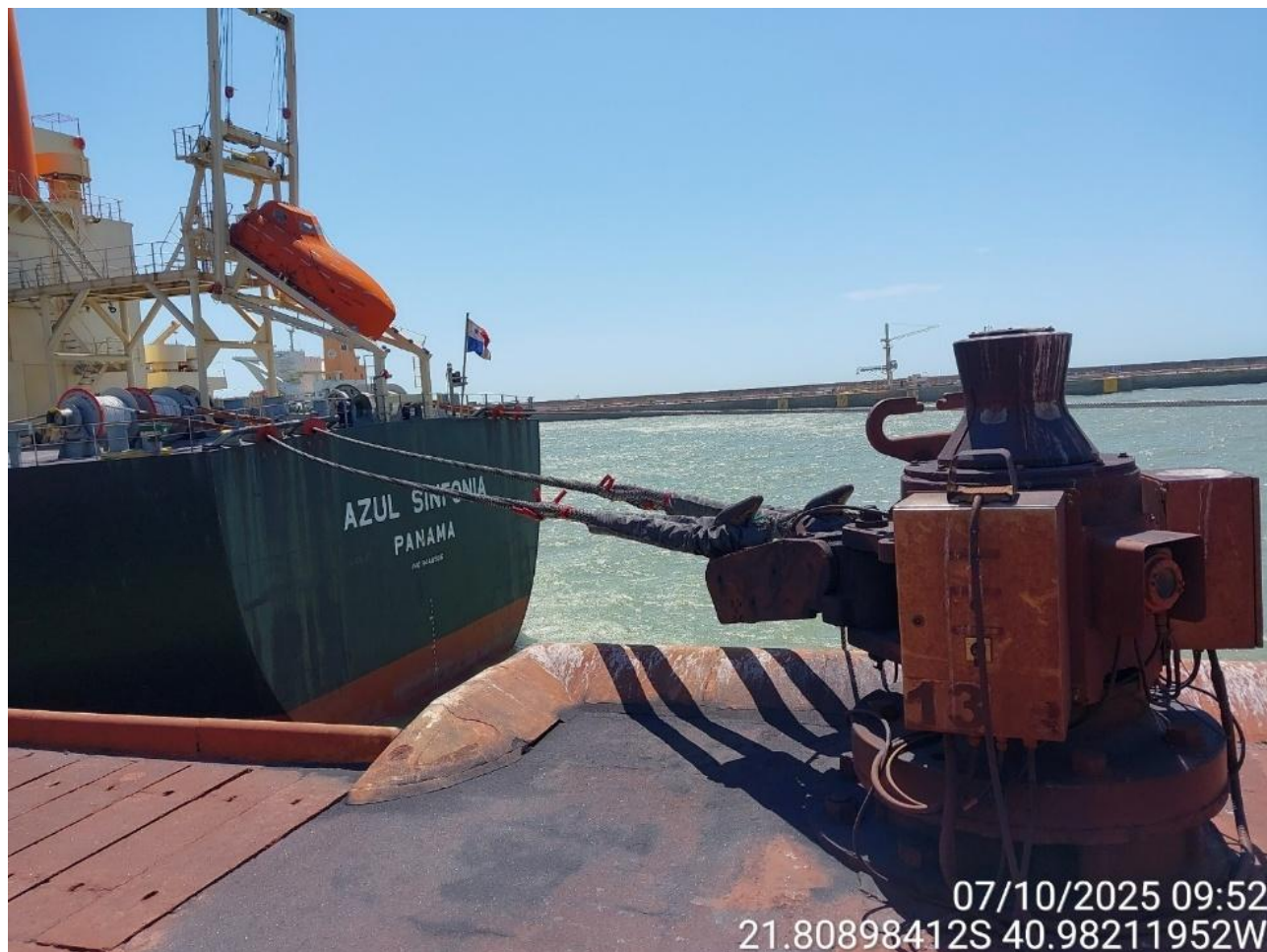
Figura 6 Muretas de contenção e sistema de atracação de navios
