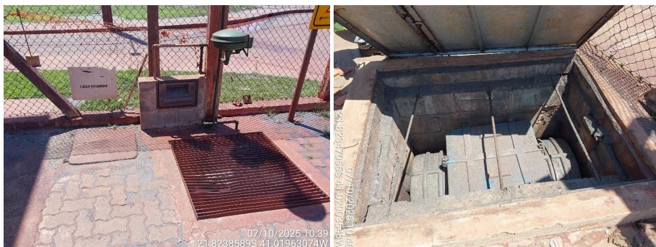
Figura 20 Caixa estanque e caixa separadora
