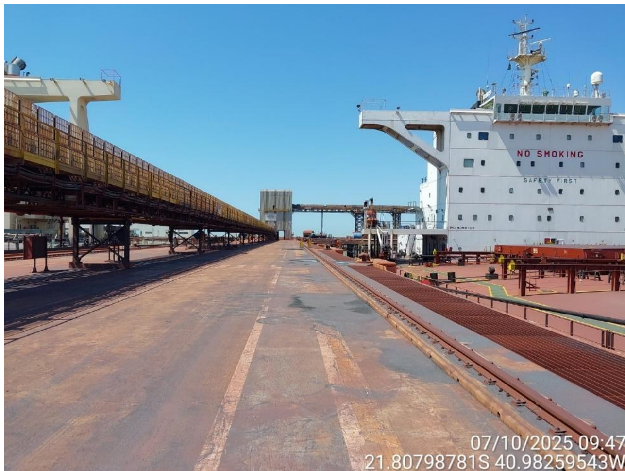
Figura 5 Sistema de canaletas no píer e condições da água
