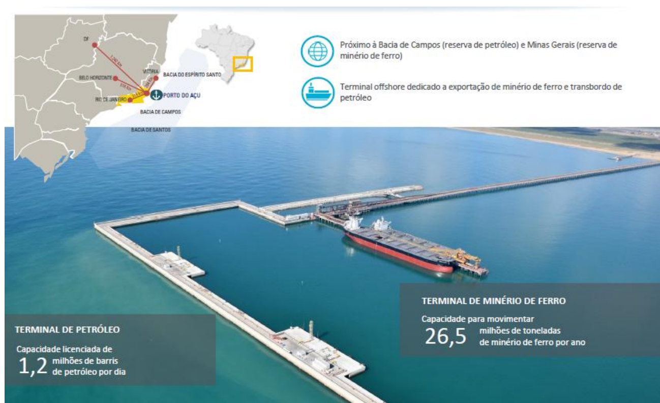
Figura 2 – Localização Terminal Ferroport
