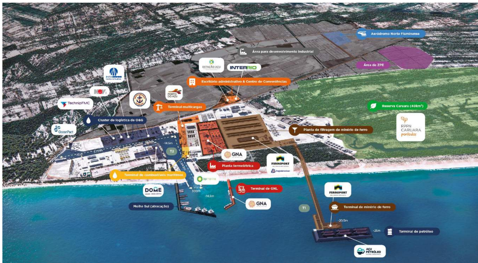
Figura 4.3 – Instalações localizadas no Porto do Açu.
